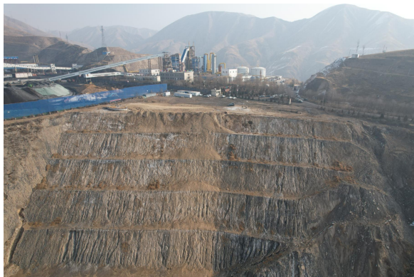
图 3.4-3 劳力土湾矸石场治理现状照片
