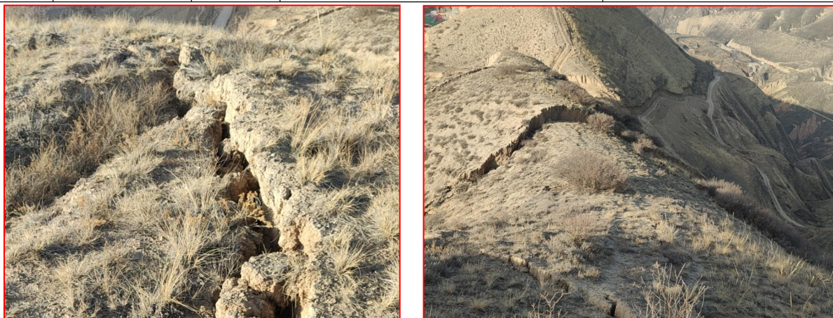
图3.4-1 海石湾煤矿塌陷裂缝
